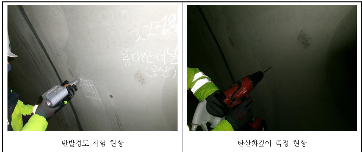
【사진 1.4.1】 콘크리트 내구성조사 현황
