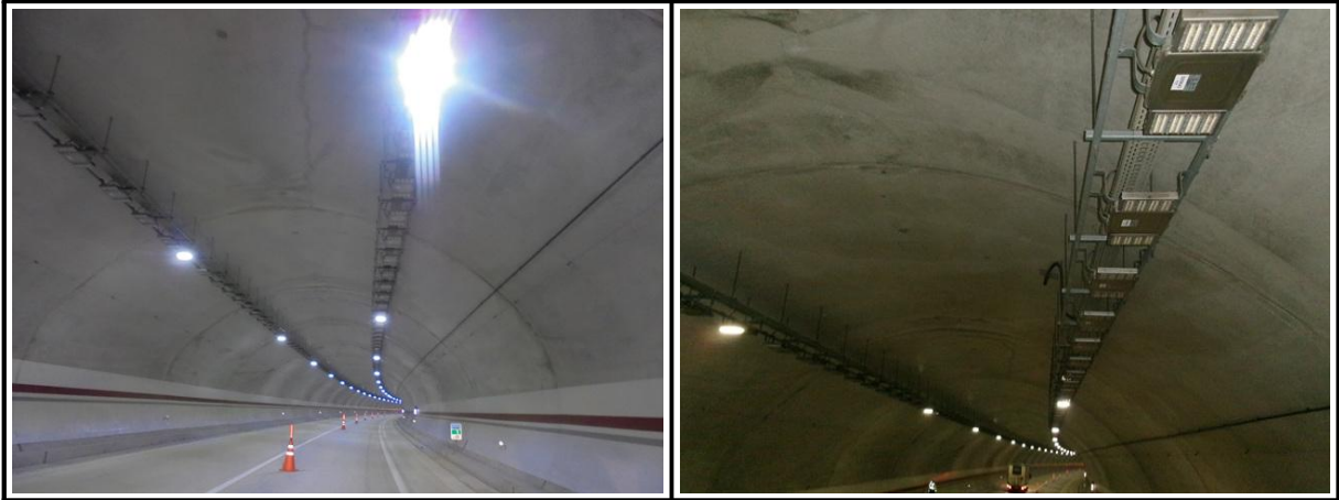
【사진 1.3.1】 라이닝 천단부 전경
