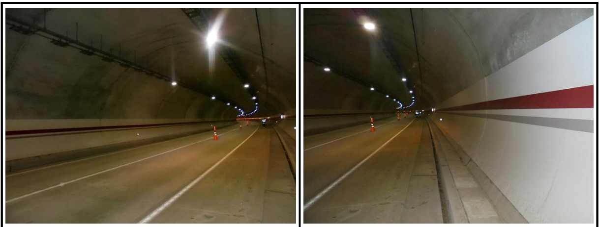
【사진 1.3.16】 라이닝 측벽부 전경
