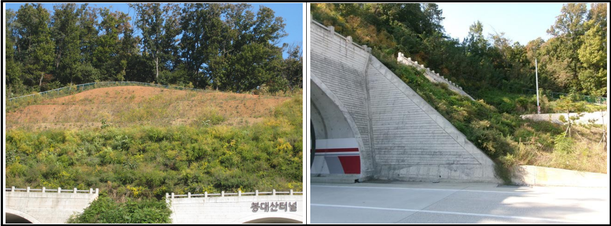
【사진 1.3.20】 사면 전경
