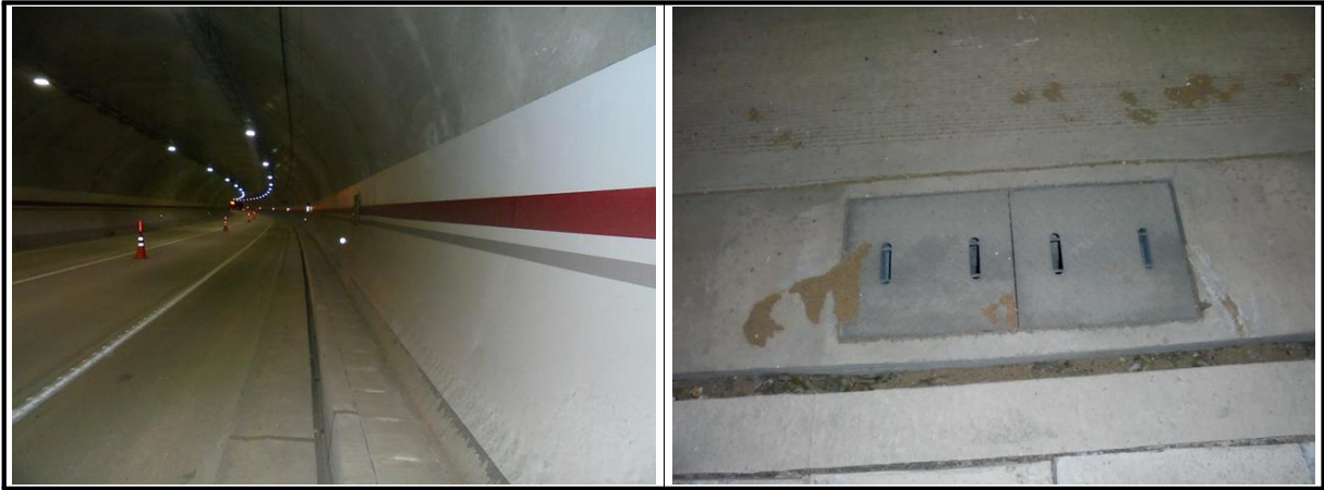
【사진 1.3.21】 공동구 및 배수시설 전경
