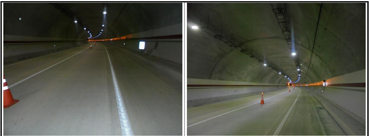
【사진 1.3.23】 포장부 전경
