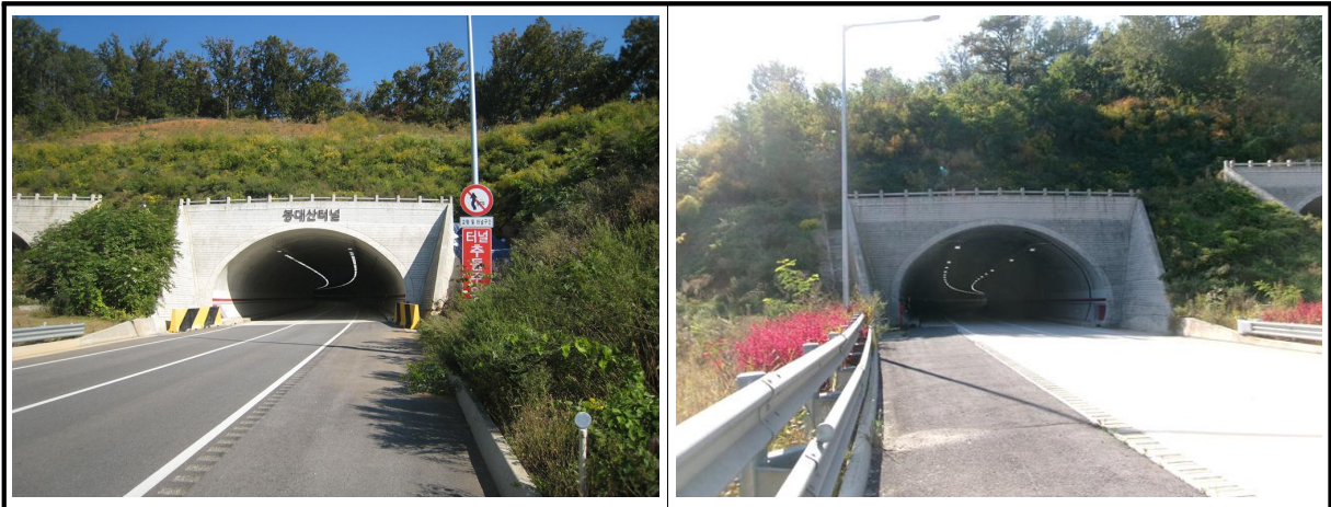
【사진 1.3.18】 갭문 전경
