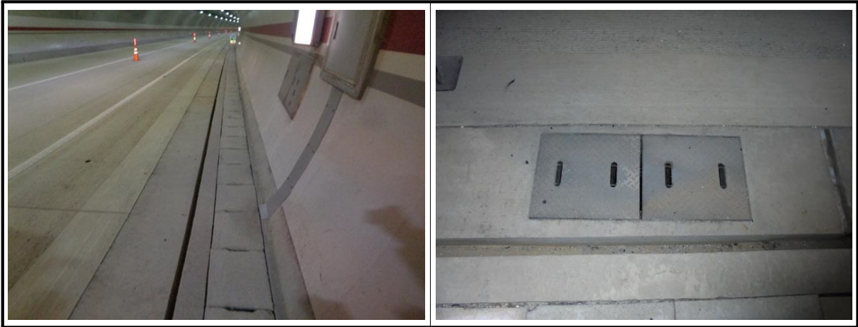
【사진 1.3.8】 공동구 및 배수시설 전경
