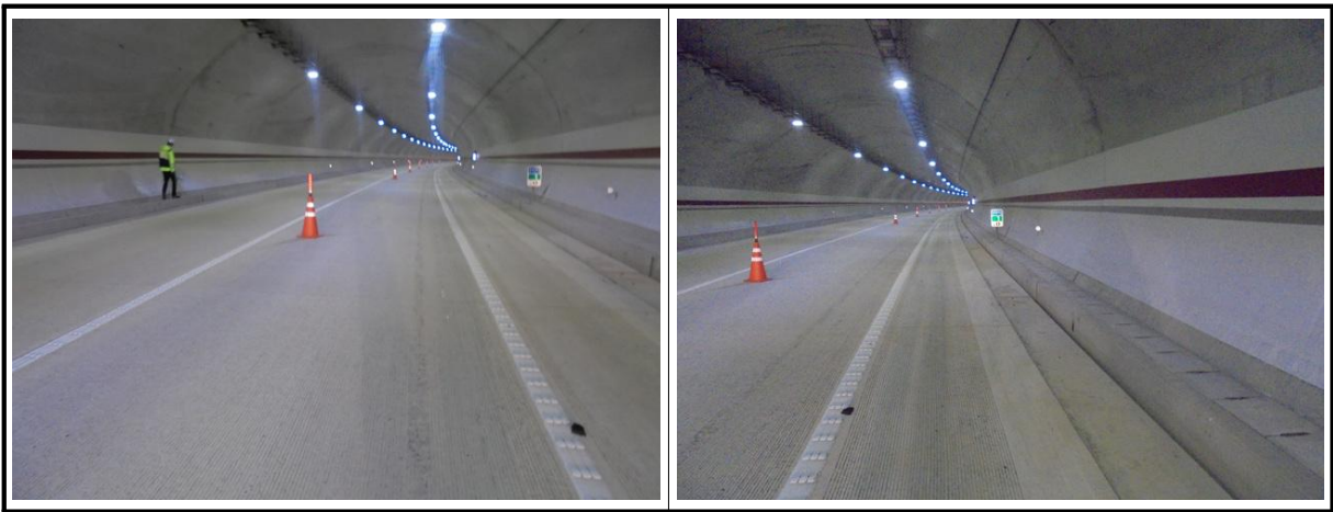
【사진 1.3.10】 포장부 전경
